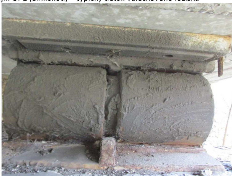
45) NK – uložení na krajní OP1 (Bílinskou) – typický detail válečkového ložiska
