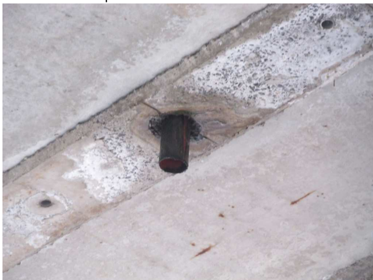
33) NK – pole č. 2, detail odvodňovače v pohledu u P2
